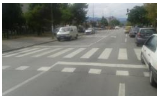
Slika 10: Pješački prelaz na uzdignutoj platformi ispred ulaza u školu
