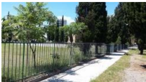
Slika 5: Ograda oko dvorišta škole
