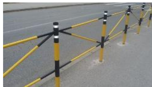
Slika 6: Izgled zaštitne ograde za pješake
